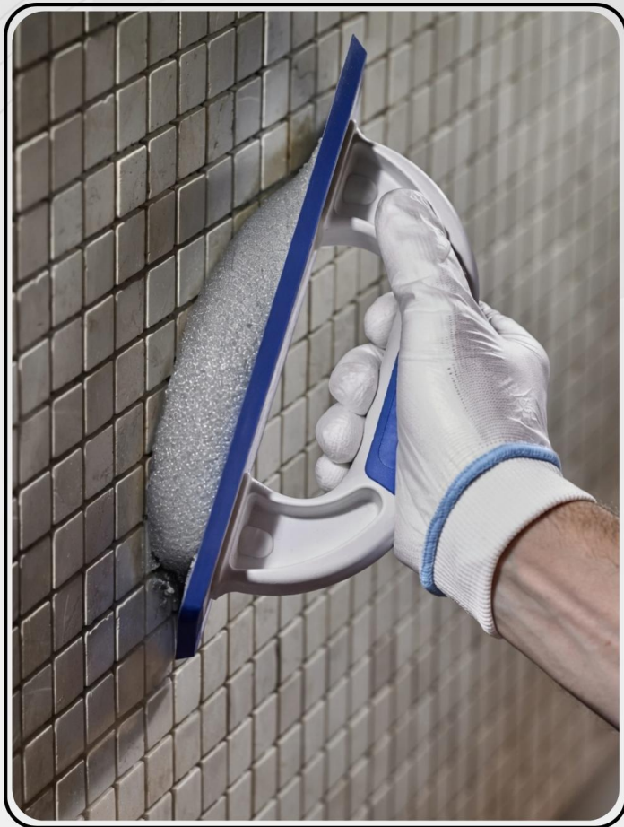
ЭПОКСИДНАЯ ЗАТИРКА В МОКРЫХ ЗОНАХ
